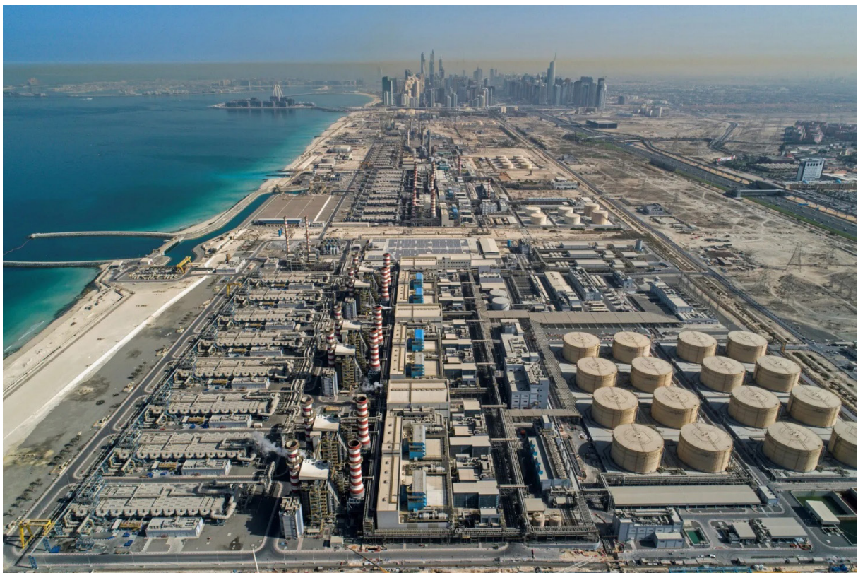
FIGURA 7 – Usina de Dessalinização Jebel Ali em Dubai
