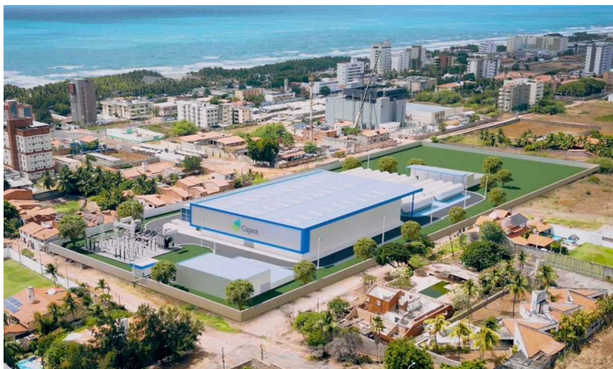
FIGURA 15 – Usina de Dessalinização de Fortaleza
