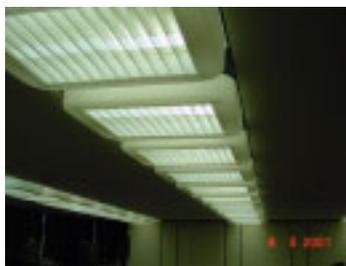
A opção adotada pela manutenção do local foi à modificação do difusor, através de cortes no acrílico, possibilitando facilitar a passagem do fluxo luminoso. A eficiência do conjunto aumentou bastante (cerca de duas vezes), para pontos de medição localizados exatamente abaixo da luminária. O investimento foi mínimo tornando a opção interessante. O fato é que a melhoria da
