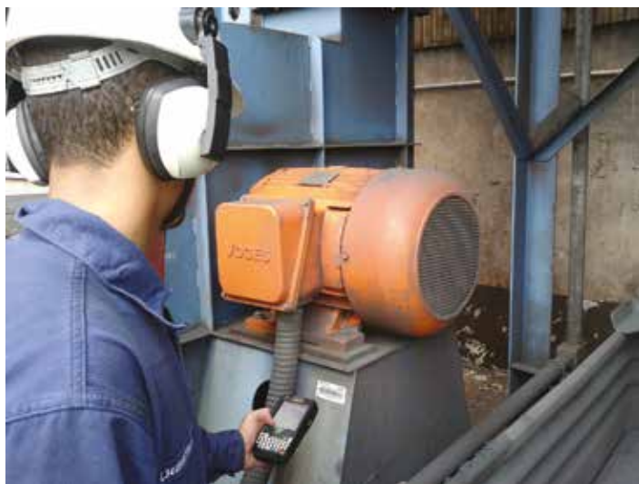
Figura 1 - Rastreabilidade dos dados durante a realização da inspeção
