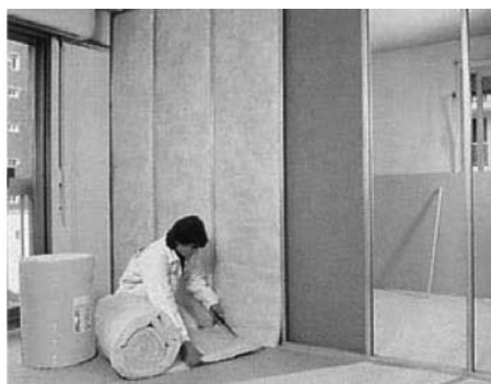
Figura 50 – Preenchimento da parede de drywall com lã de vidro em rolo
