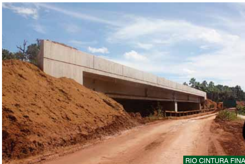
Figura 4 - Trecho 2.1 – divisa MT/PA ao Salto Curuã
