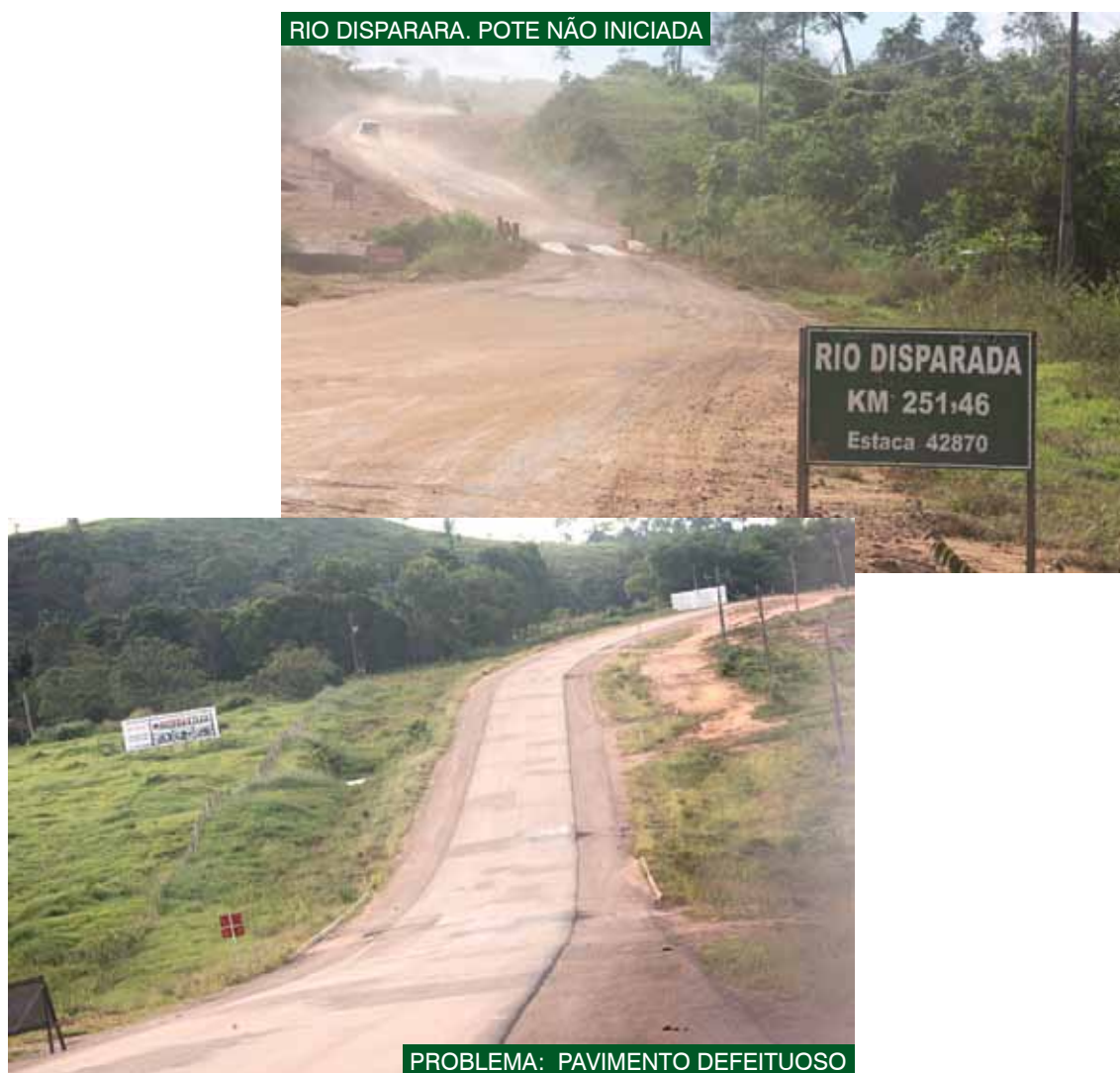
Figura 6 - Trecho 2.4 – Castelo dos Sonhos – Novo Progresso
