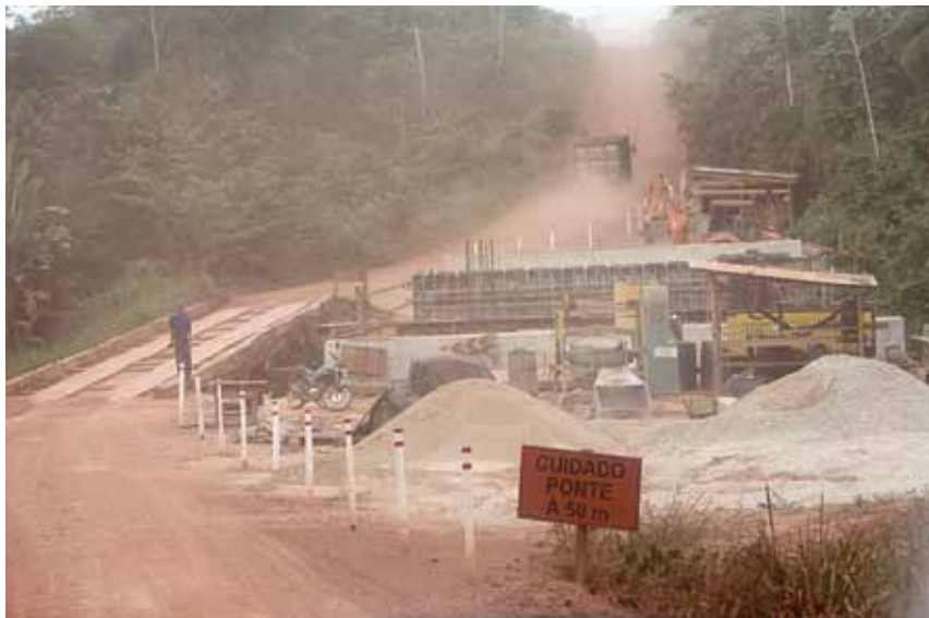
Figura 12 - Trecho 2.10 - Rio Ajuricaba – em obras (A)
