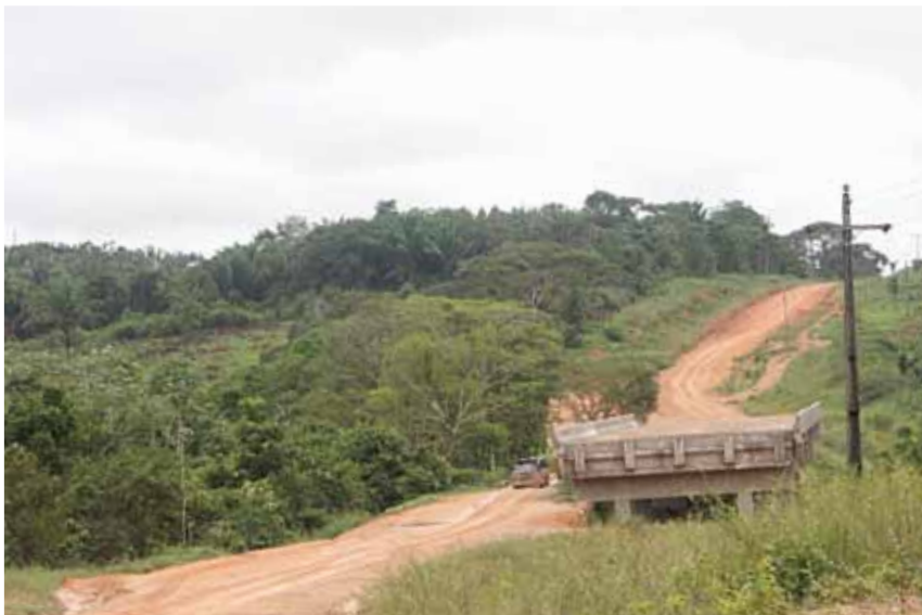
Figura 10 - Trecho 2.8 - Rio Iriri – Ponte em execução
