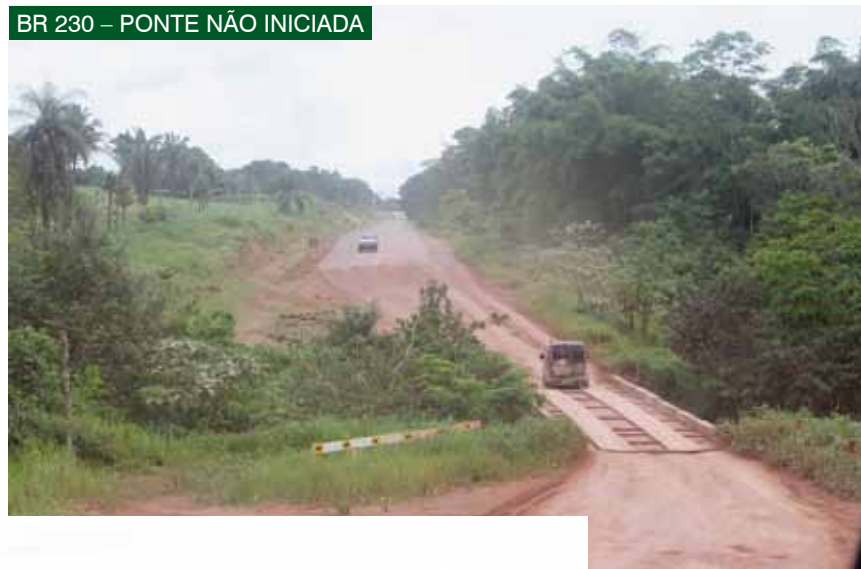
Figura 11 - Trecho 2.9 - Trecho Entroncamento BR-163 / Mirituba
