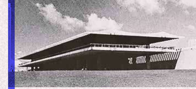
EDIFÍCIO TOURING, BRASÍLIA - DF, POR OSCAR NIEMEYER
