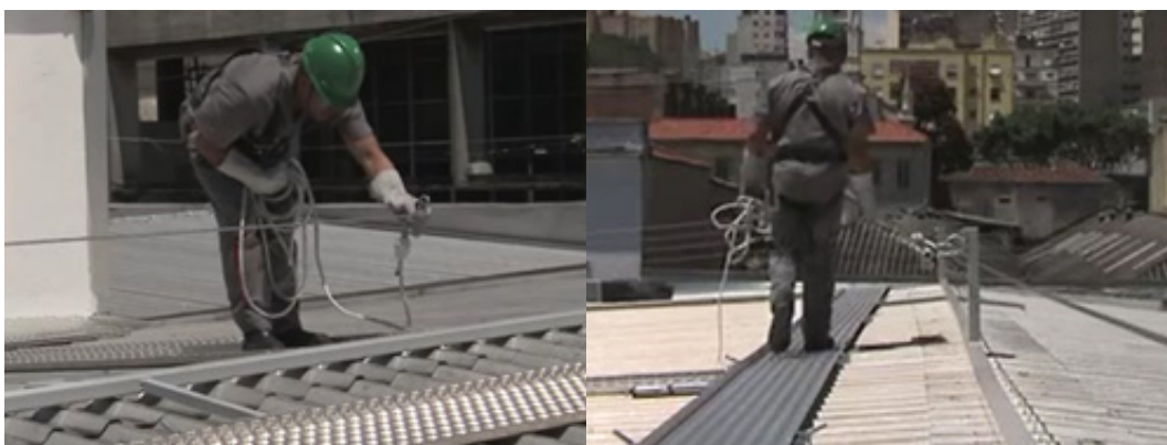
Figura 133 - Serviços de Manutenção em Telhados
