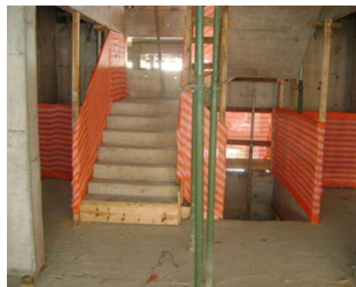
Figura 6 - GcR em Escadas
