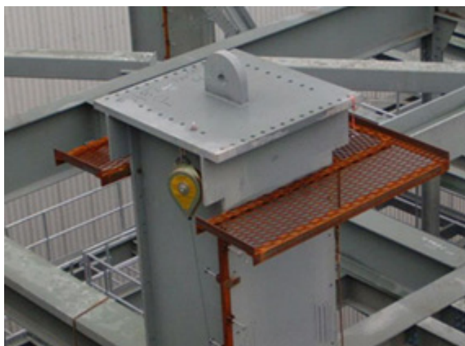
Figura 127 - Técnica de Acesso Seguro às Posições de Trabalho Temporário: Plataforma de Segurança
