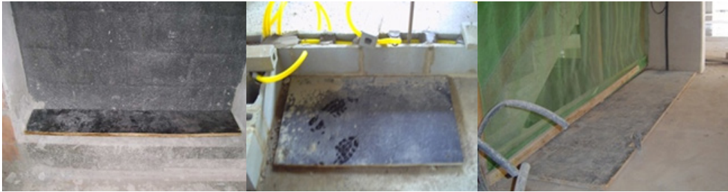
Figura 20 - Fechamento de Shaft's com Madeira
