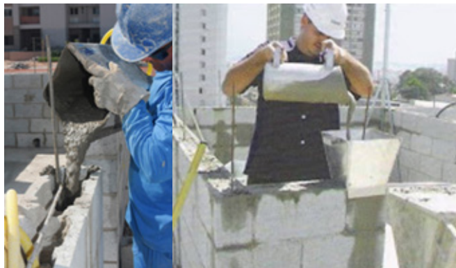
Figura 113 - Grauteamento da Alvenaria
