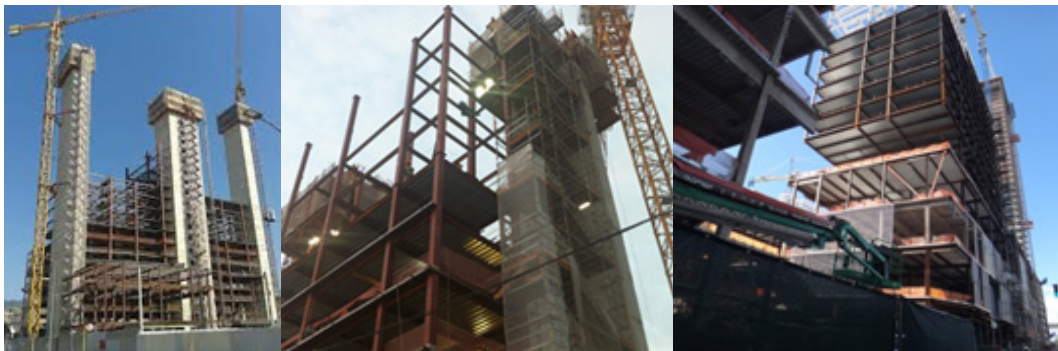
Figura 125 - Montagem de Estruturas Metálicas
