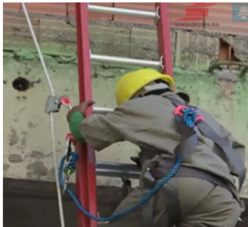
Figura 58 - Utilização de Escada com Trava-queda
