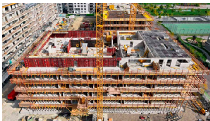
Figura 1 - Proteção contra Queda em Fachadas
