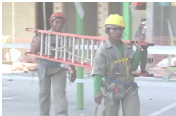
Figura 52 - Transporte de Escada
