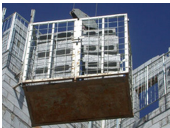
Figura 107 - Içamento de Blocos
