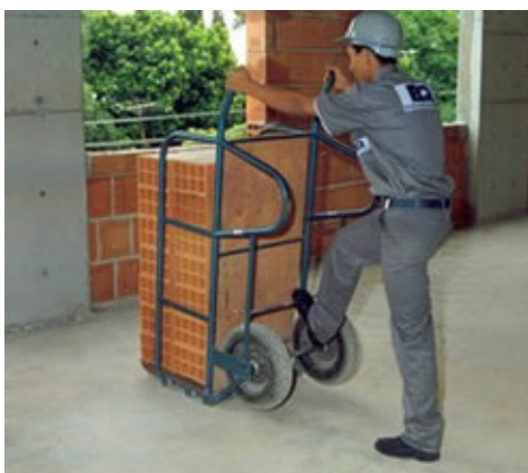
Figura 106 - Transporte Manual de Blocos
