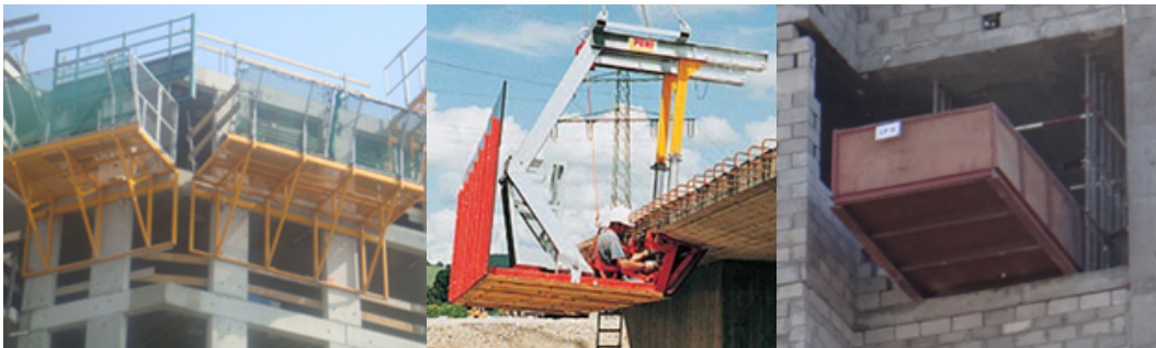
Figura 68 – Andaime sem balanço
