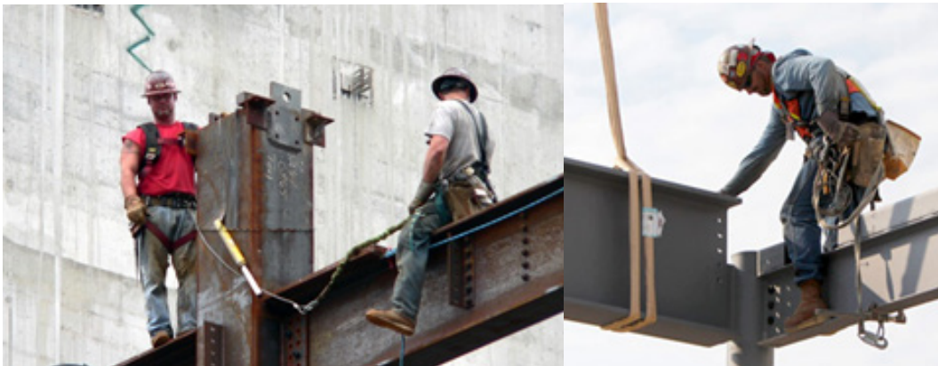
Figura 126 - Técnica para Acesso Temporário: “Montar a Cavalos” ou Beam Straddling.
