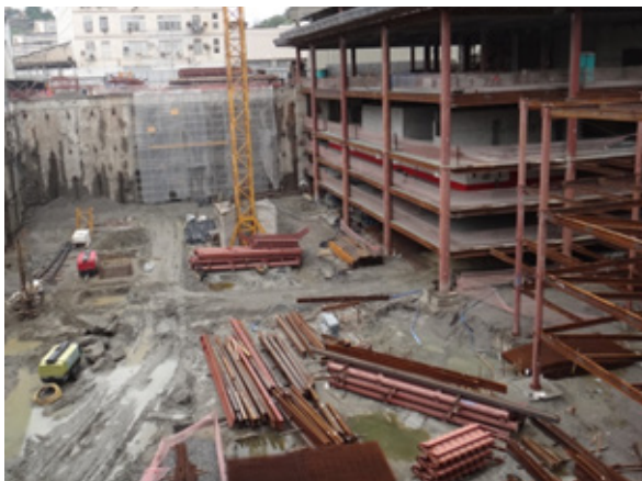
Figura 123 - Armazenamento de Perfis Metálicos
