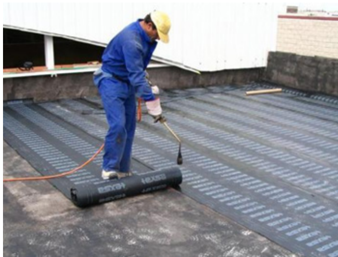
Figura 157 - Serviço de Impermeabilização
