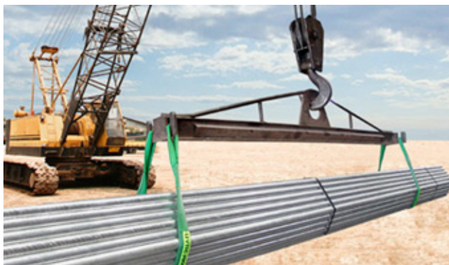
Figura 94 - Içamento com Pórtico e Cinta
