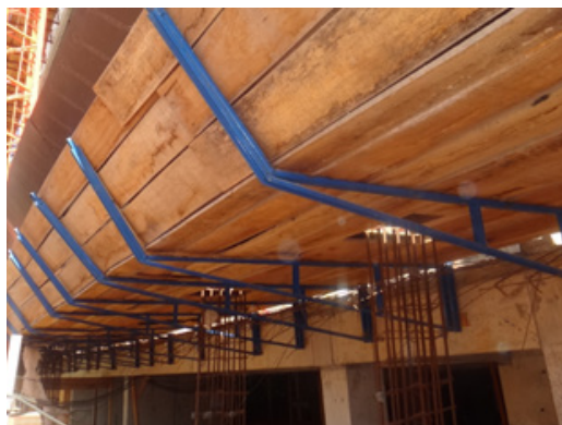
Figura 27 - Plataforma de Madeira
