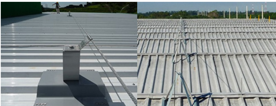
Figura 138 - Linhas de Vida fixas para Telhados
