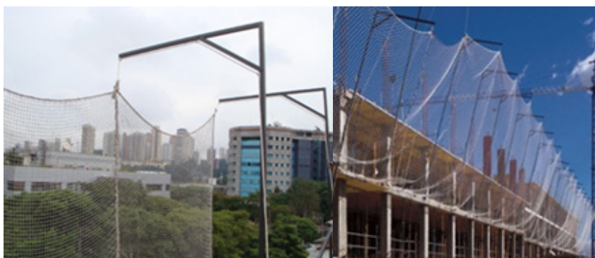
Figura 31 - Estrutura Metálica para a Colocação da Rede de Segurança
