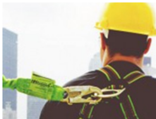
Figura 39 - Utilização de Cinto com Absorvedor de Energia
