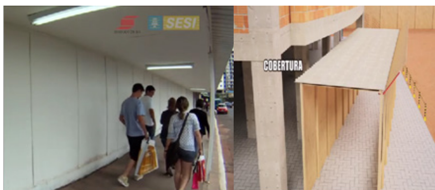
Figura 162 - Exemplos de Galerias de Obras
