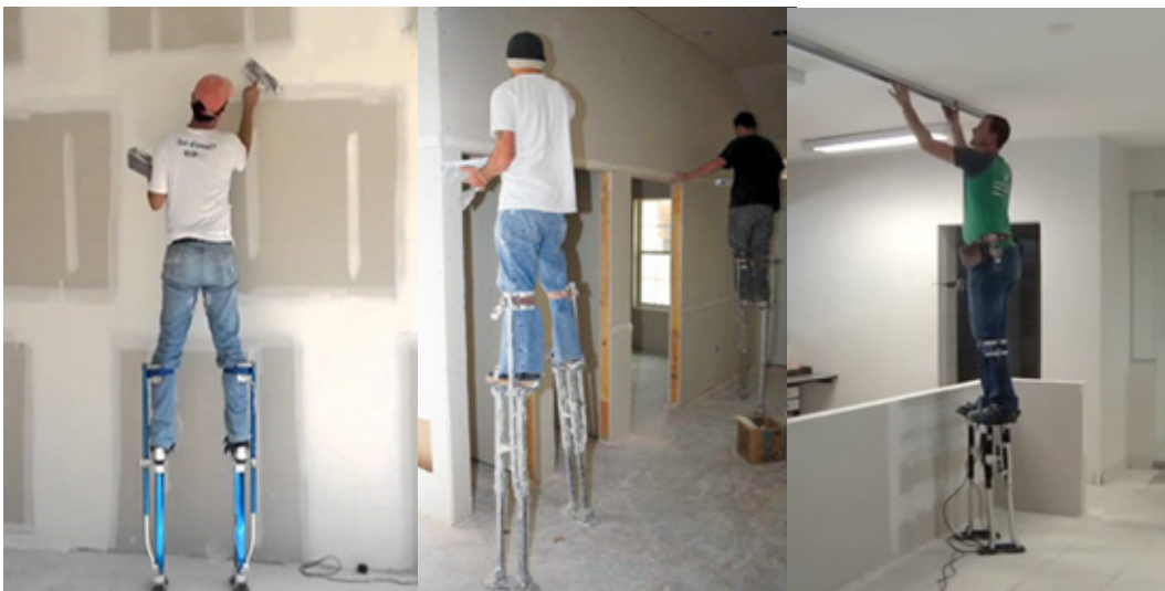
Figura 114 - Perna Mecânica
