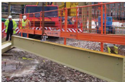
Figura 115 - Proteção de Periferia Fixa na Viga antes do Içamento
