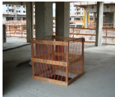
Figura 22 - Fechamento de Aberturas com GcR
