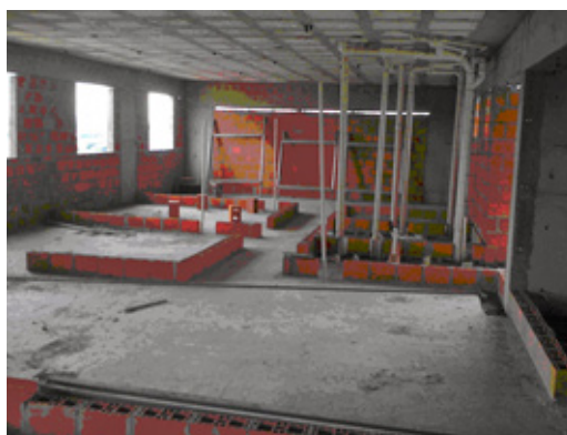
Figura 108 - Marcação da Alvenaria
