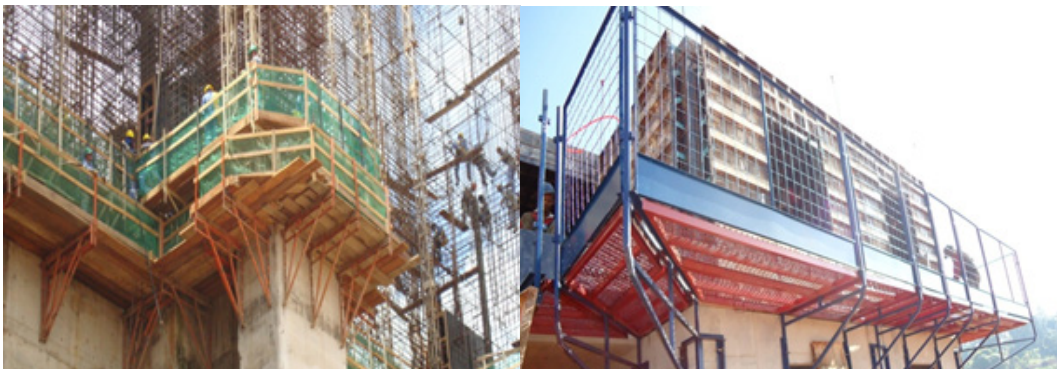
Figura 12 - Guarda-Corpos em Andaime em Balanço
