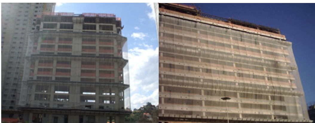
Figura 28 - Plataforma de Proteção e Tela
