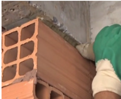
Figura 110 - Fixação da Alvenaria
