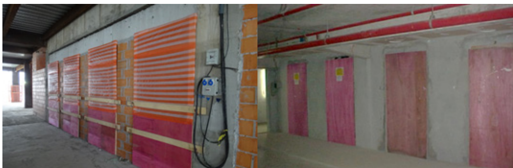
Figura 18 - Fechamento das Aberturas de Acesso aos Locais dos Futuros Elevadores
