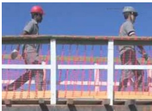
Figura 7 - GcR em Passarelas
