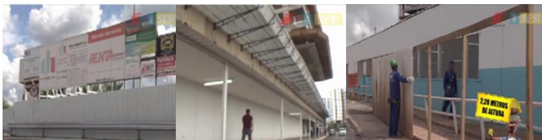
Figura 161 - Exemplos de Tapumes de Obras
