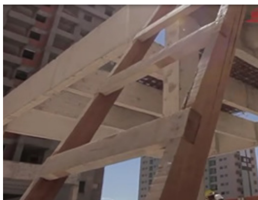
Figura 50 - Montagem de Escada de Mão com Cavi-lhas
