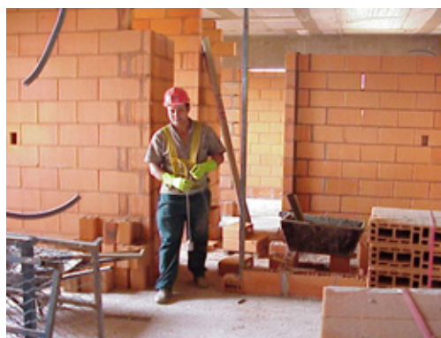
Figura 109 - Elevação da Alvenaria
