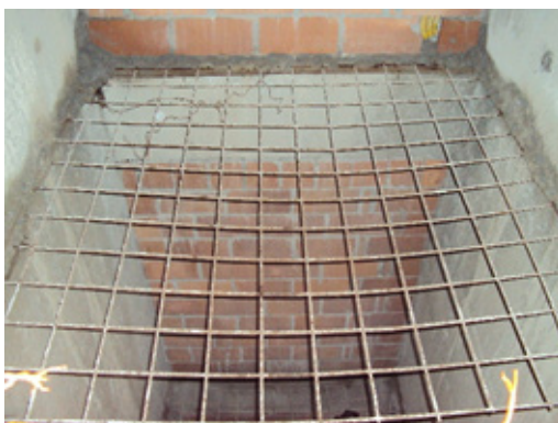
Figura 23 - Primeiro o Fechamento com Tela de Aço
