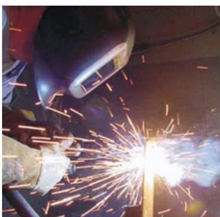
Figura 120 - Soldagem a Arco Elétrico
