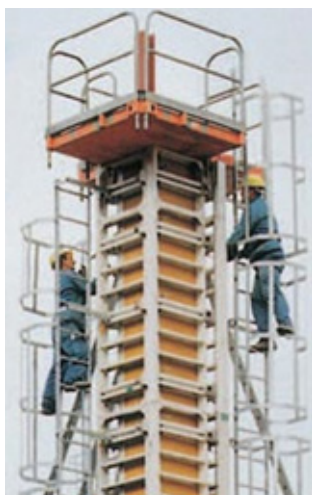
Figura 47 - Escada Tipo Marinheiro com Gaiola
