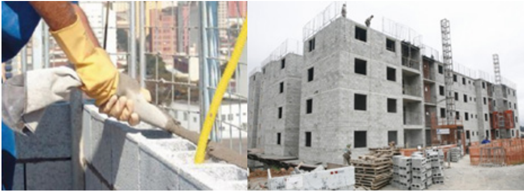
Figura 112 - Elevação de Alvenaria
