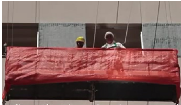
Figura 15 - Guarda-Corpos em Andaime Suspenso Motorizado
