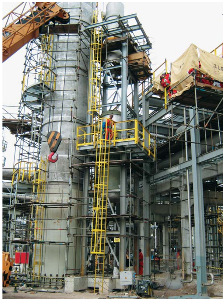
Funcionários da ZLS montam grandes estruturas metálicas
