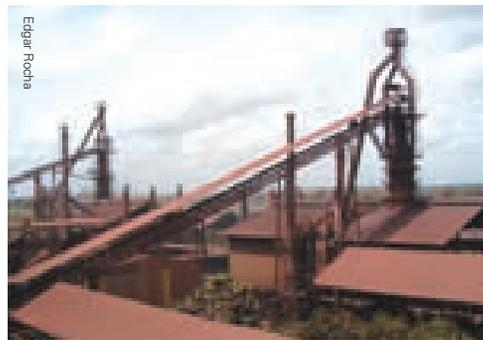
Todas as operações são monitoradas em salas de controle localizadas em Carajás e São Luís, dotadas de equipamentos de alta tecnologia, que garantem maior produtividade e segurança. Uma usina de beneficiamento moderna assegura o produto em três granulometrias distintas – o pellet feed, o sinter feed e o granulado. O sistema tem capacidade para produzir 85 milhões de toneladas/ano.
