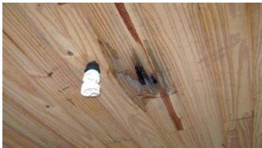
Figura 14: Teto do escritório do laticínio com infiltração e desenvolvimento de bolores
