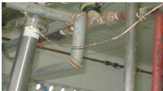
Figura 19: Tubulação do pasteurizador com amarrações, sujidades e ferrugem
