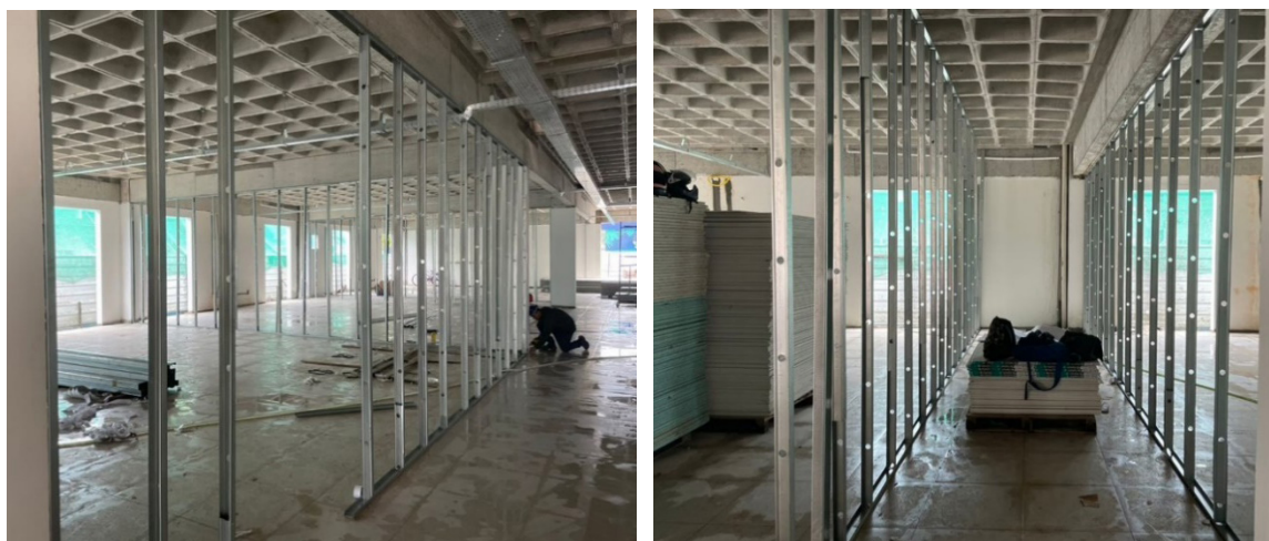
FIGURA 6 – Imagens ilustrativas, vedações em drywall (gesso acartonado), obra ESR
