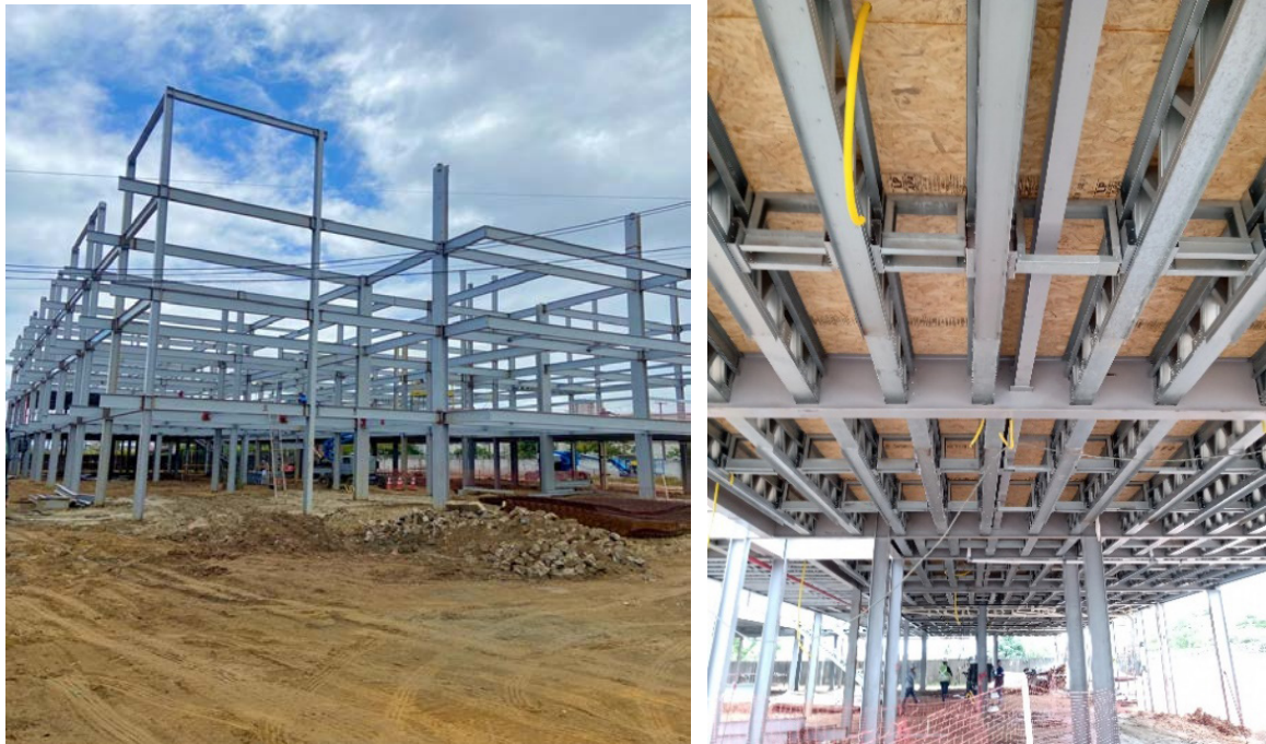
FIGURA 5 – Imagens ilustrativas, construção em Steel Frame - obra ESR
