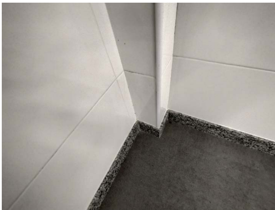
FIGURA 21 – Imagem ilustrativa da obra ESR, rodapé em pedra (granito) assentado em piso vinílico, altura igual a 7cm, fornecedor local, conforme especificação e detalhamento adequado ao piso do projeto.
