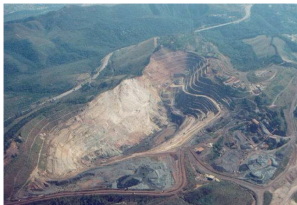
Figura 5- Aproveitamento da cava exaurida da Mutuca para co-disposição de rejeitos e estéril
