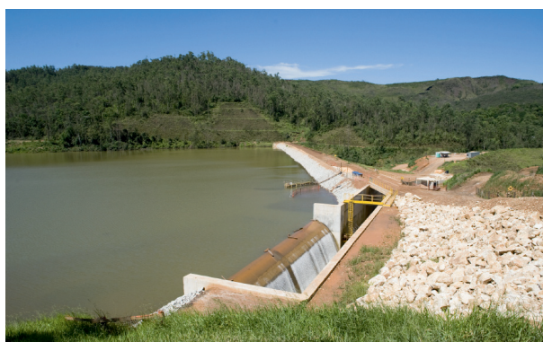
Figura 3- Barragem de rejeitos de mineração
