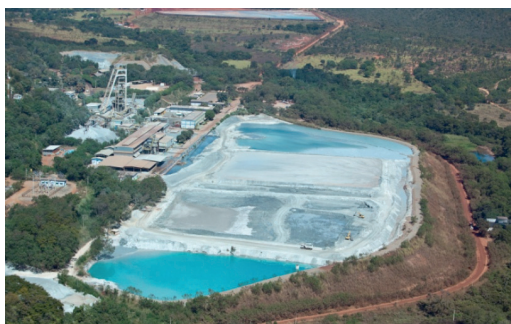
Figura 6- Vista geral das bacias de armazenamento de rejeitos, observando-se também as instalações industriais e o cavalete do poço de acesso à mina subterrânea.
