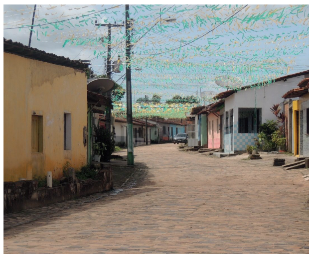
Figura 2 - Tijolos refratários usados na pavimentação de ruas do bairro Pedrinhas, em São Luís (MA).
