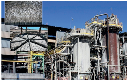
Figura 7- Vista das instalações de flotação, onde inovações incrementais foram necessárias para melhor controle de qualidade.
