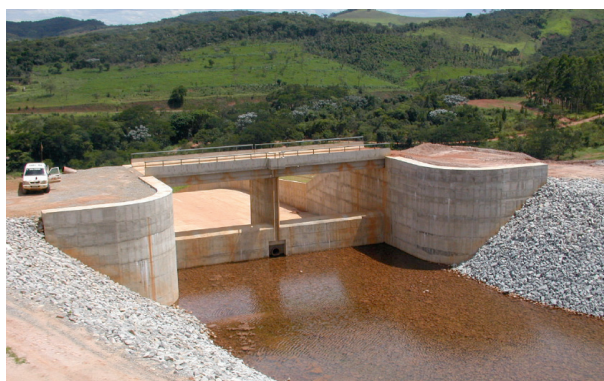
Figura 4- Barragem de rejeitos de mineração
