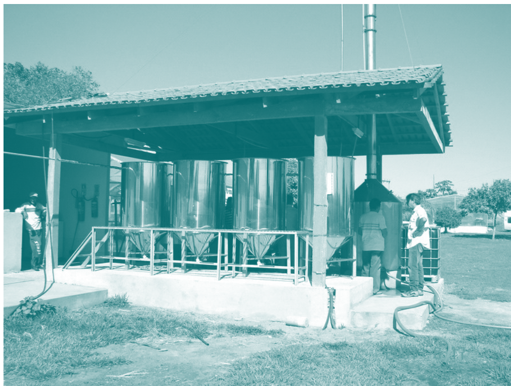
Foto 4: Miniusina produtora de etanol, a partir da batata-doce, instalada na Estação Experimental da Universidade Federal do Tocantins – capacidade 300l/dia. Campus de Palmas, Tocantins, 2007.
