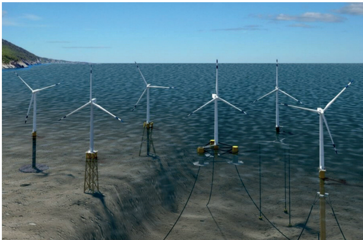
FIGURA 15 – Tipos de fundação eólica offshore
