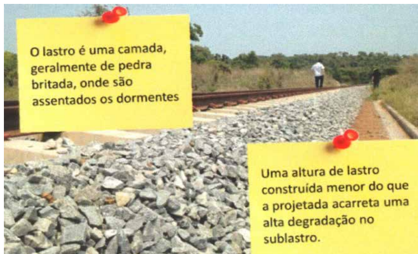
Figura 6 – Registros fotográficos da auditoria do TCU: lastro
