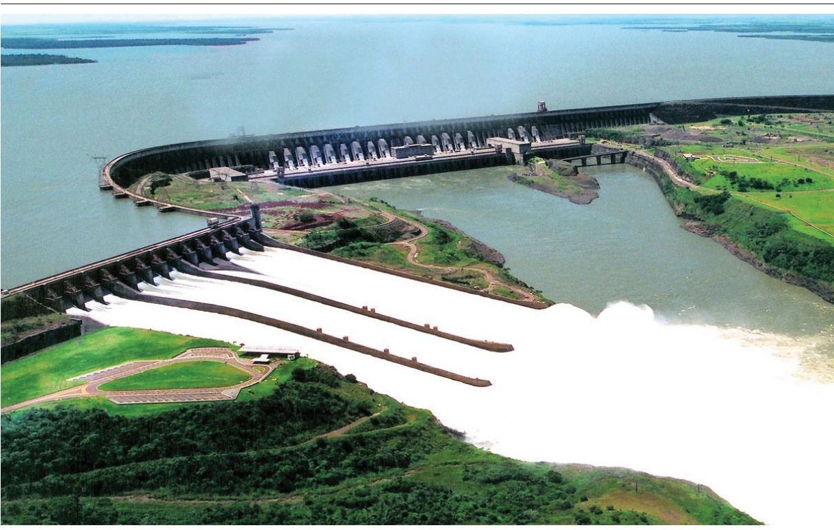
Figura 1 - Usina Hidrelétrica Itaipu Binacional, Foz do Iguaçu, Paraná
