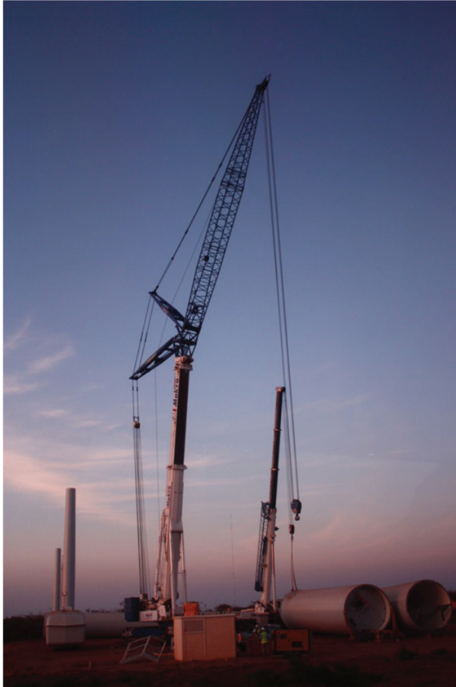
Figura 9 - Implantação do Parque Eólico Morro dos Ventos – João Câmara, Rio Grande do Norte
