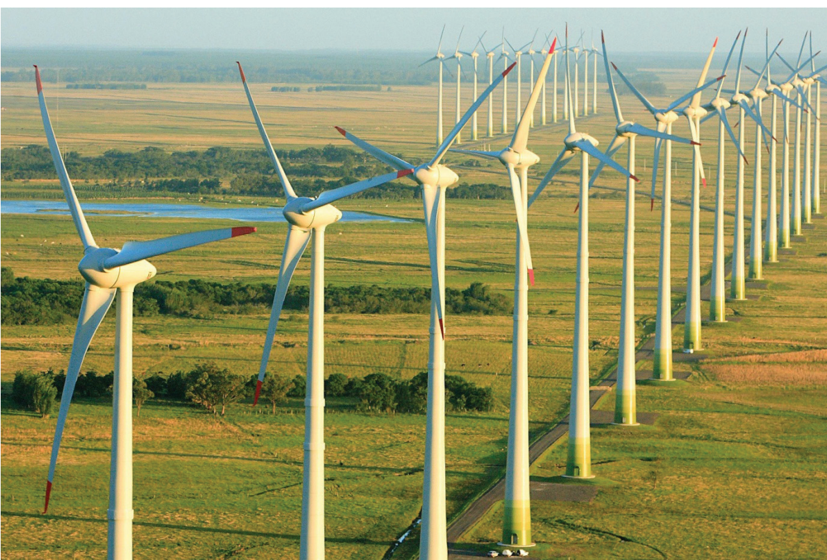
Figura 2 - Implantação do Parque Eólico Morro dos Ventos - João Câmara, Rio Grande do Norte
