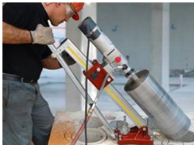
Figura 48 - Máquina de Perfuração e Corte de Concreto
