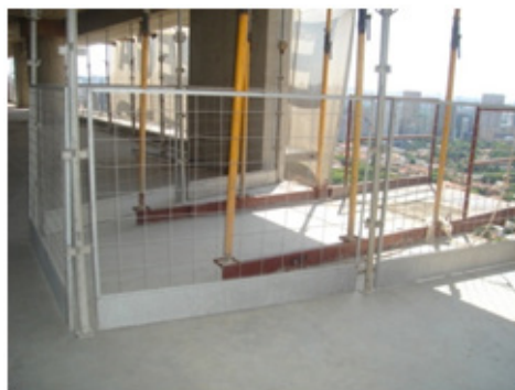
Figura 63 - Plataformas em Balanço para Descarregamento de Cargas
