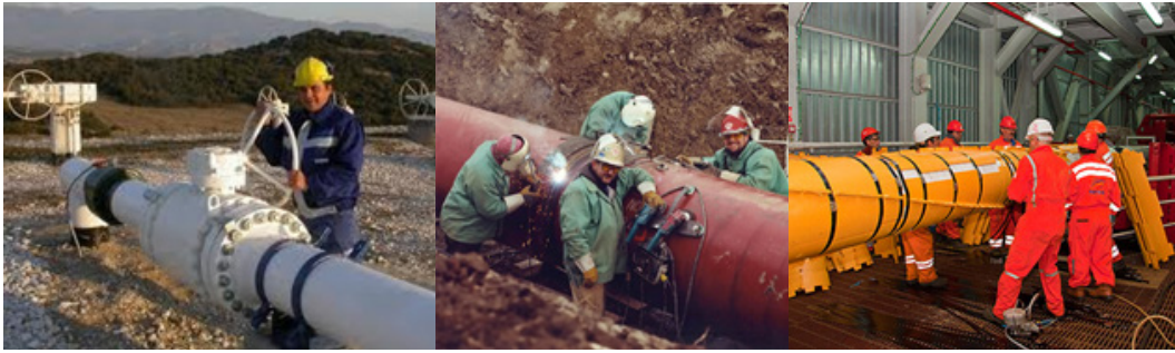
Figura 130 - Trabalhos de "Tie-in"
