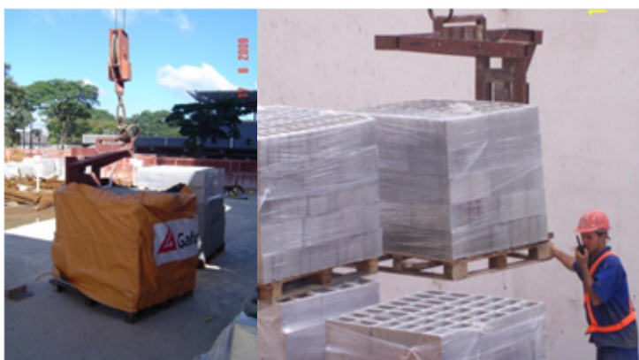
Figura 64 - Içamento de Pallet com Grua
