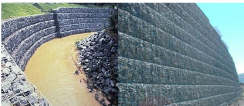
Figura 116 - Gabião Tipo Caixa
